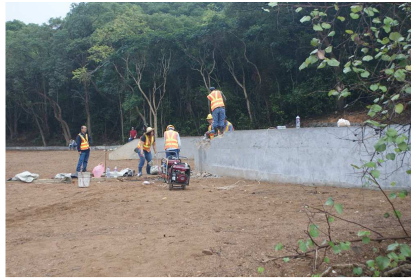
清拆霸佔官地
