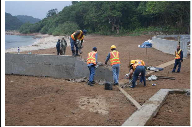
清拆霸佔官地
