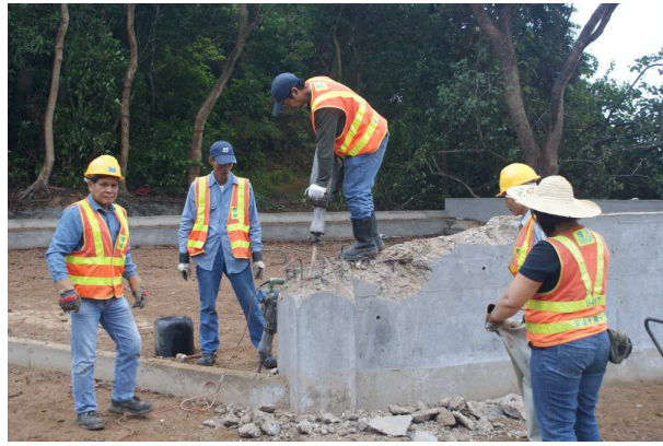
清拆霸佔官地
